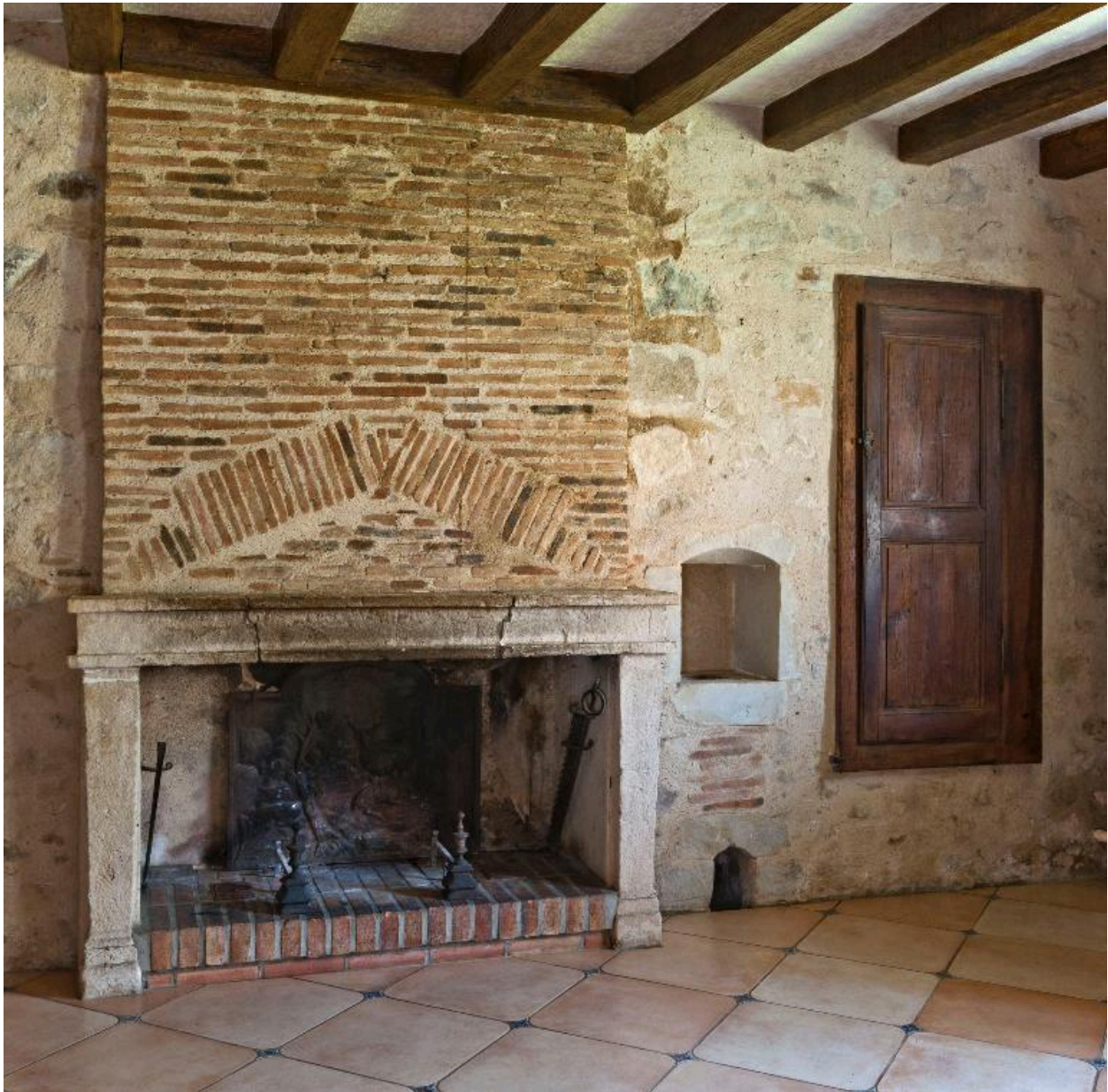
Cheminée et potager de la pièce de droite du logis.
