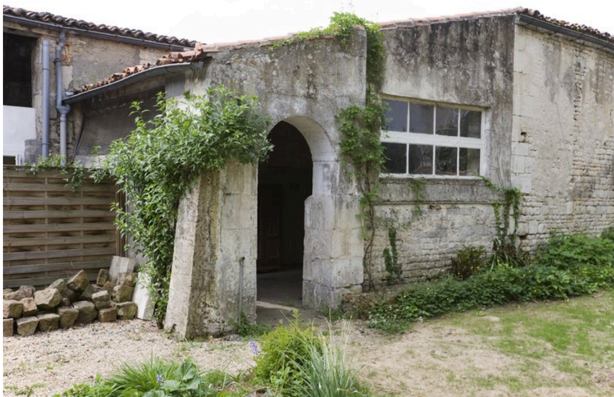
Bâtiment de commun au sud du jardin.
