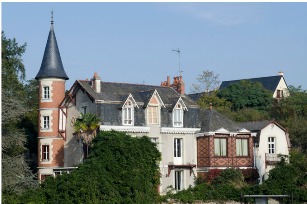
Vue depuis le sud-est.
