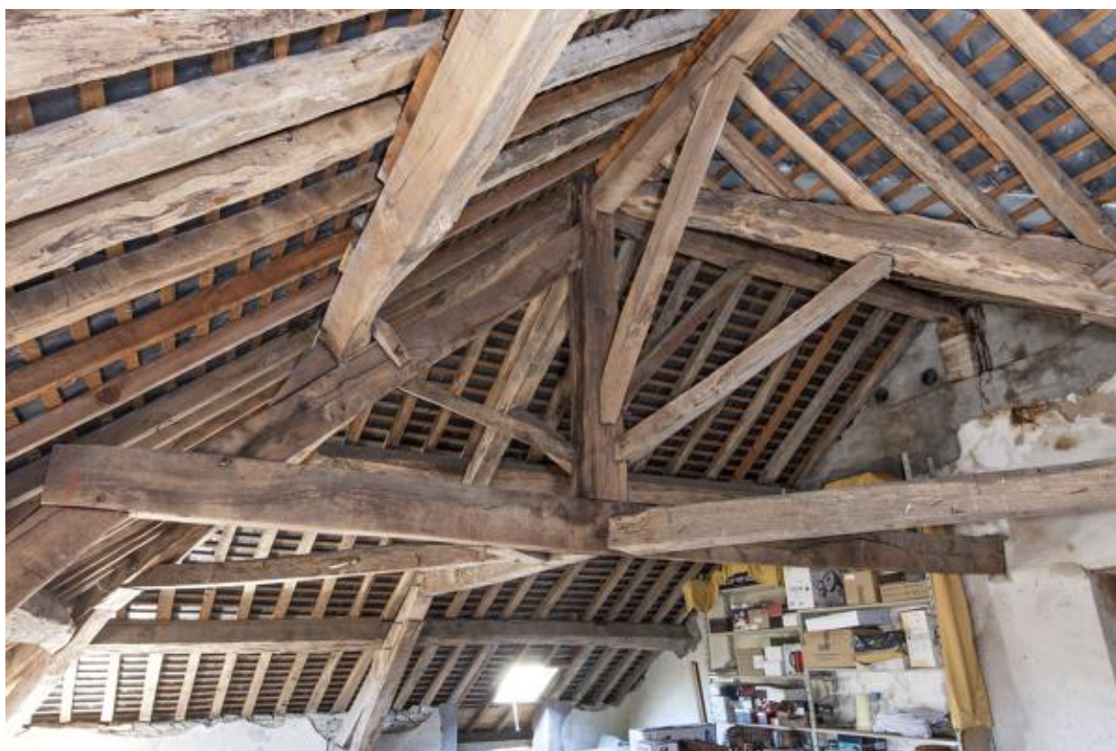
Charpente du château de la Drouardière.
