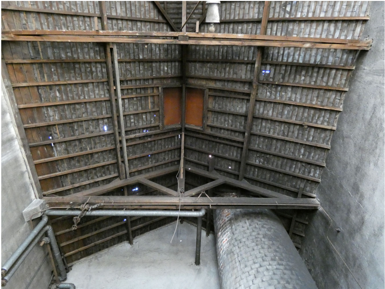
La charpente de la chaufferie.
