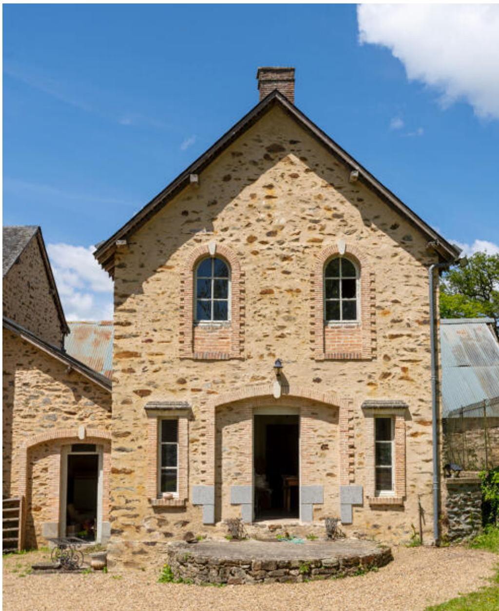
Les communs, détail du logis du personnel.
