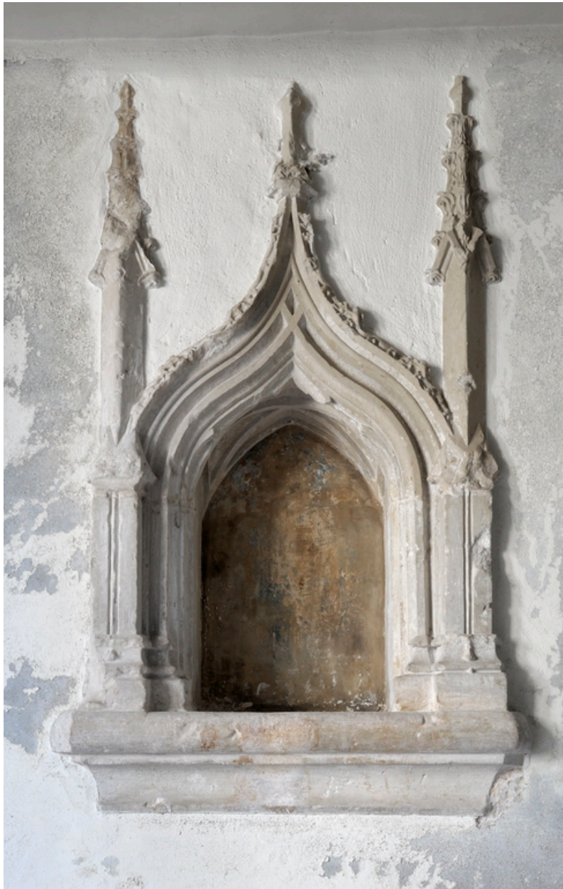
Ancienne chapelle nord (fin XVe siècle), RdC, mur sud : niche-crédence à décor flamboyant.
