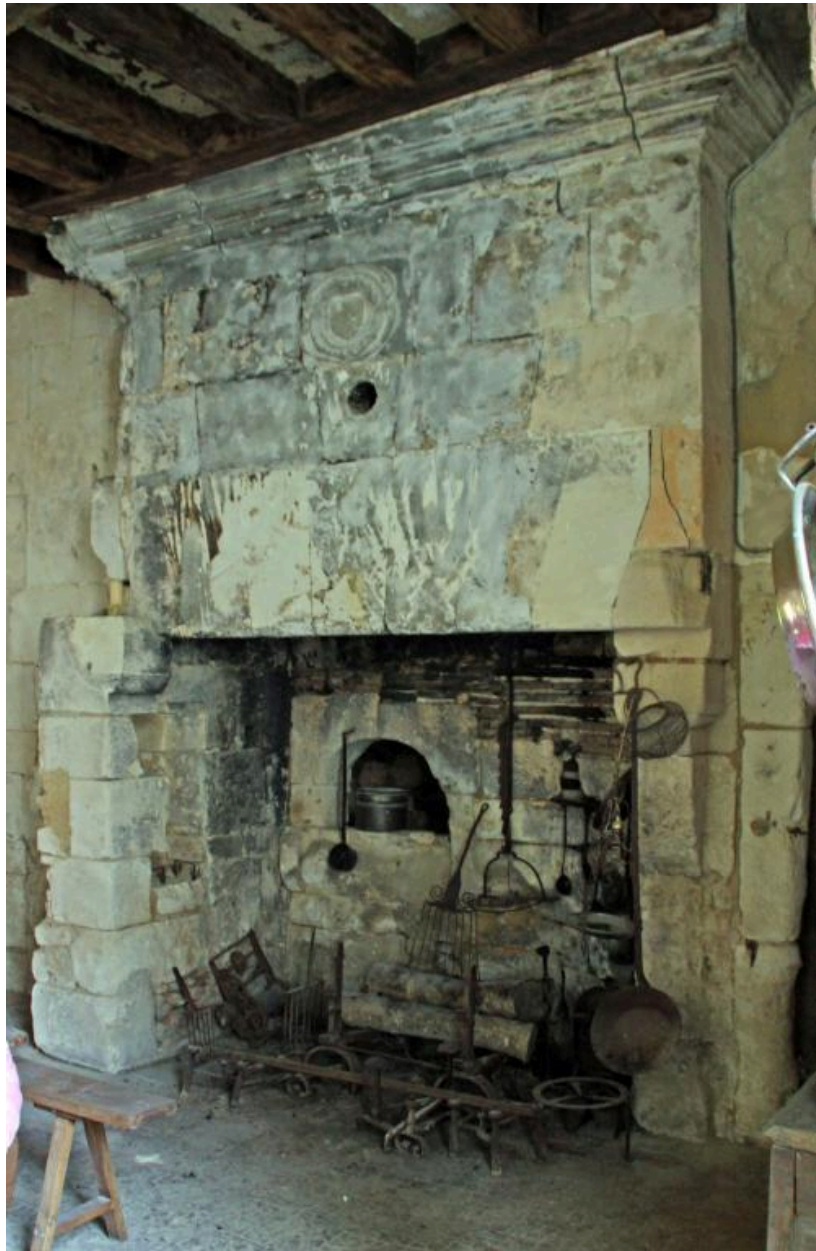
Corps central, rez-de-chaussée, pièce à feu côté cour : cheminée.
