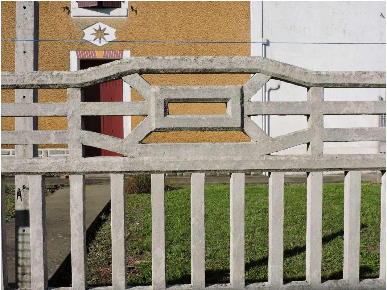
Détail de la clôture ajourée.
