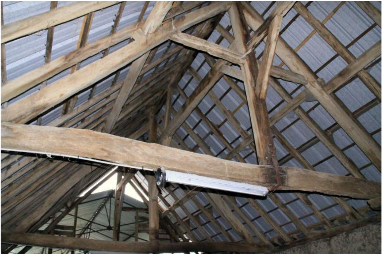
Grange : détail de la charpente.
