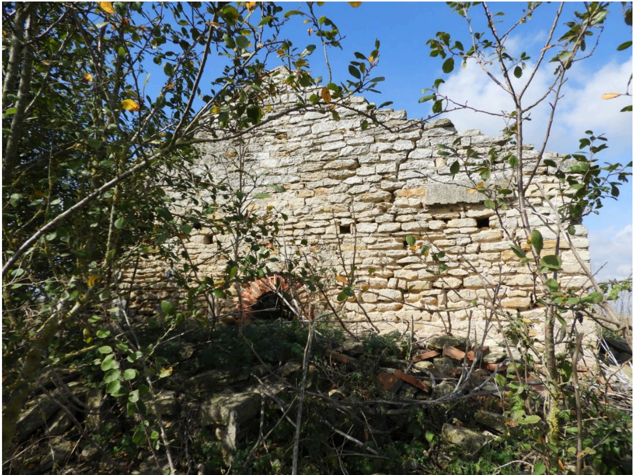
Vestiges du fournil dans le prolongement est du logis, vus depuis l'est.
