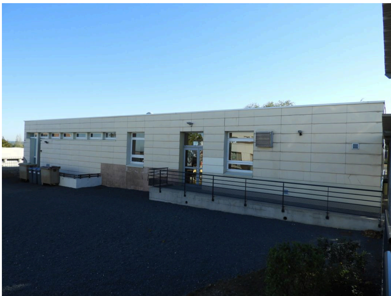
Le réfectoire vu depuis le sud-ouest.
