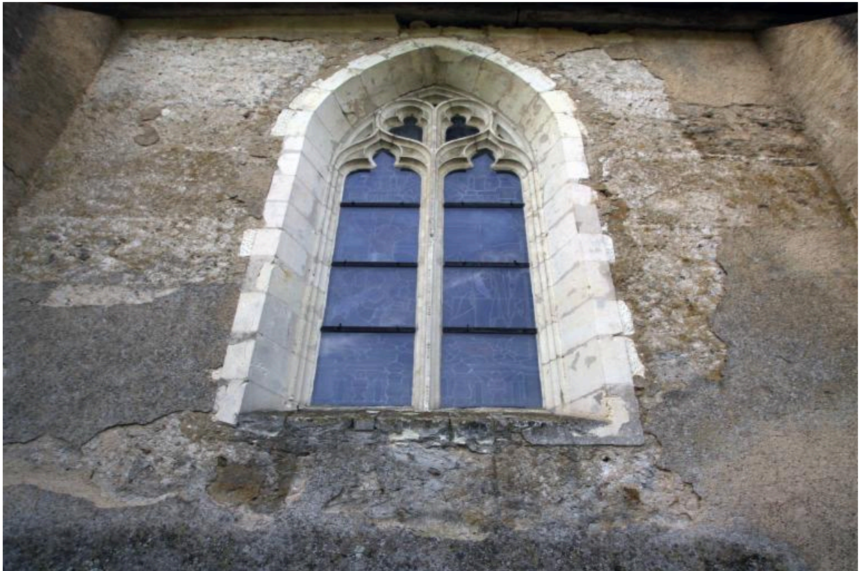
Chœur, façade nord, détail : traces d'une litre.
