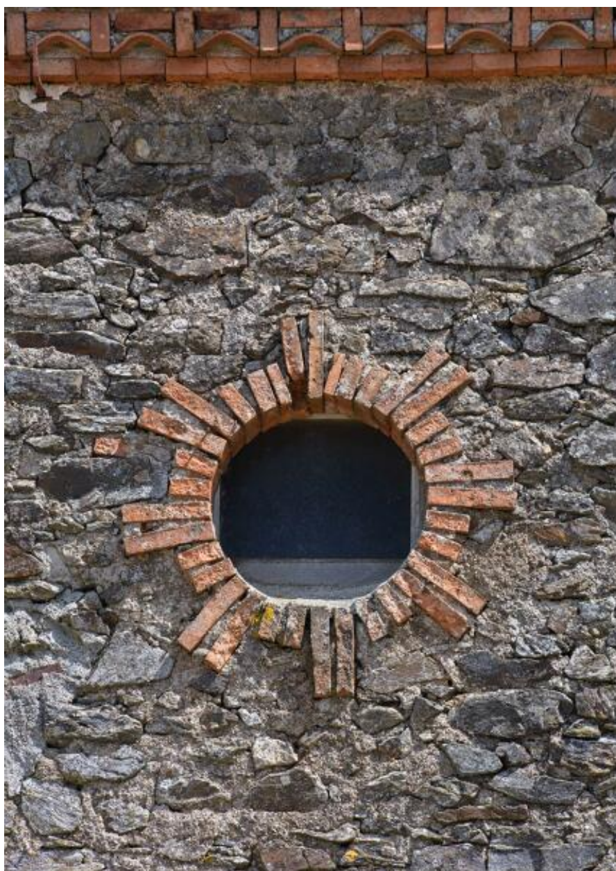
Façade ouest. Détail d'un oculus en brique.
