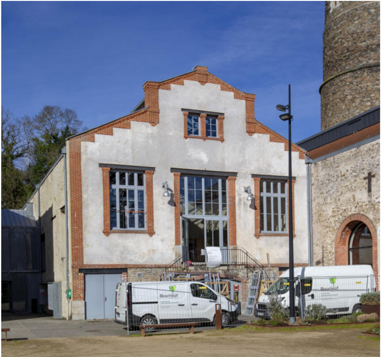
Façade antérieure de l'ancienne centrale électrique de l'usine.
