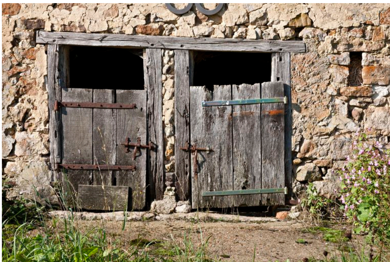
Porte de la partie gauche des étables.
