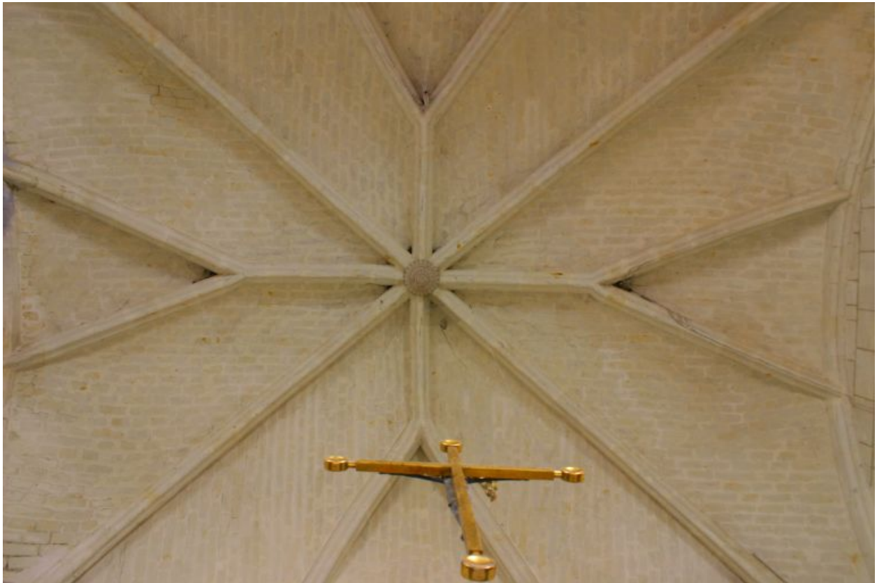
Voûte du chœur.
