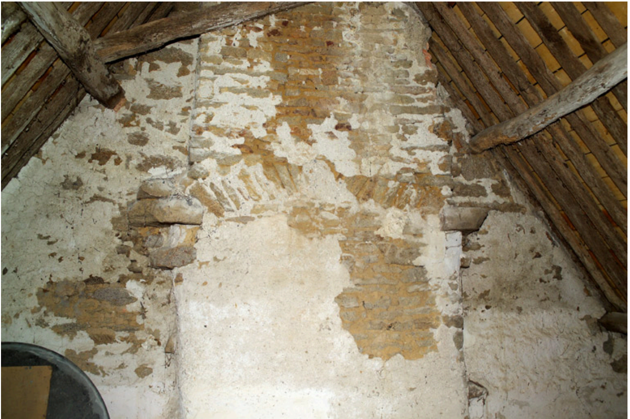
Comble, partie supérieure du conduit de cheminée dans le pignon méridional du logis, arc de décharge et corbeaux en moellon.
