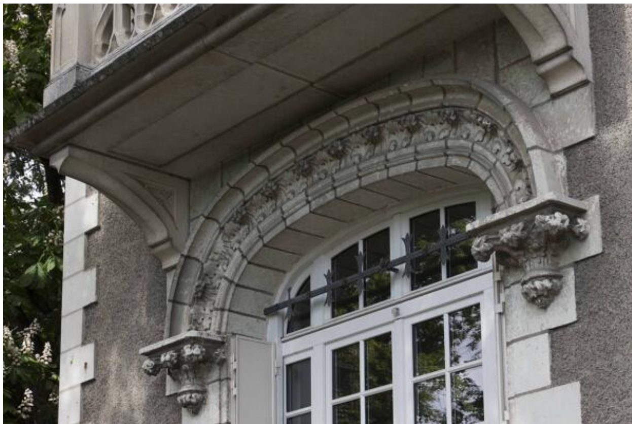
Détail de l'arc de la fenêtre du pavillon sud orné de feuilles.
