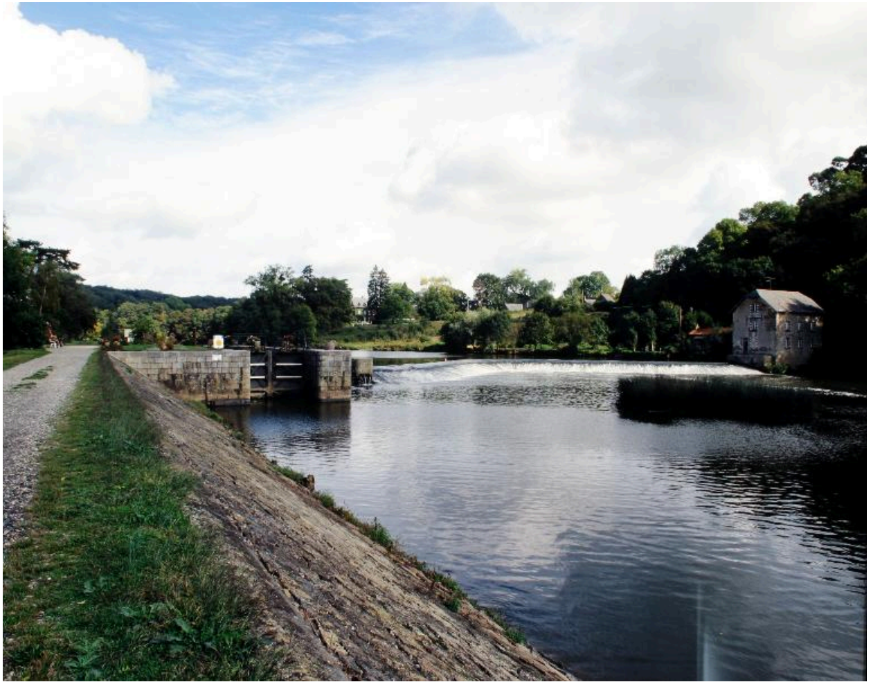
Vue d'ensemble depuis le chemin de halage, rive droite, en aval : écluse, barrage, moulin.
