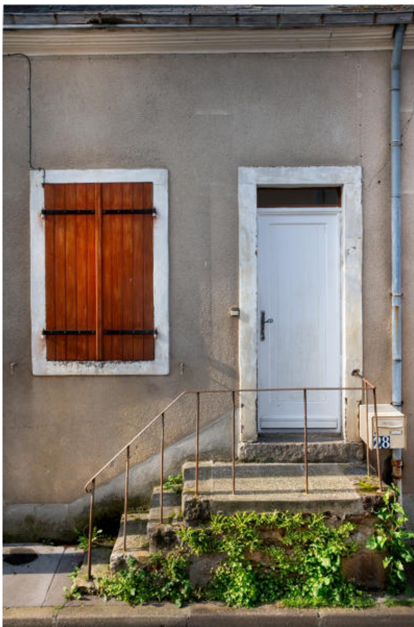
Vue d'une maison dite de tisserand rue du Tourniquet.
