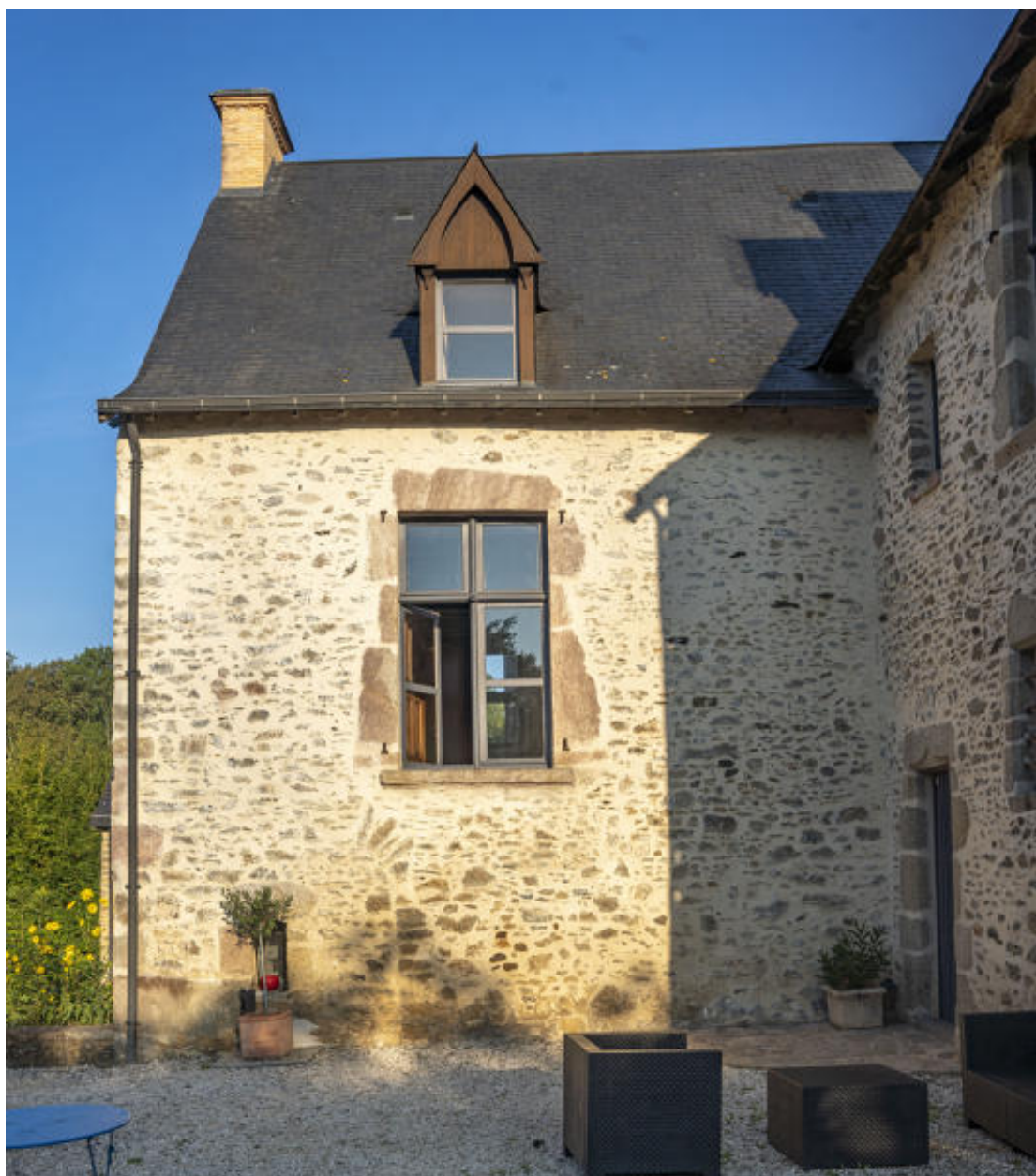
La façade antérieure du corps principal.
