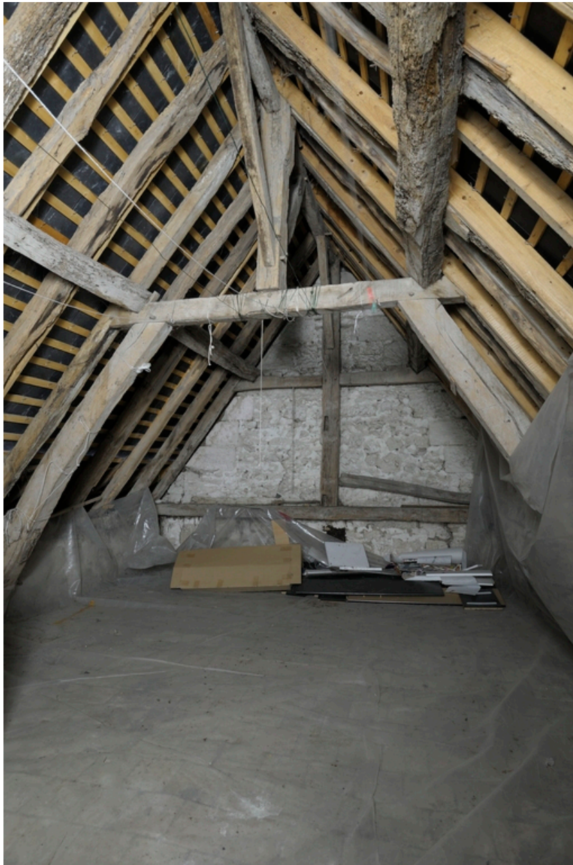
Flanquement ouest, comble. Charpente (seconde moitié XVIIe siècle).
