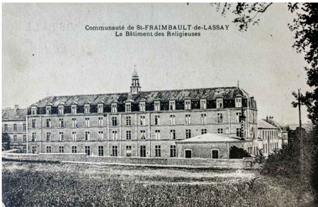
Le bâtiment des religieuses vu du nord.
