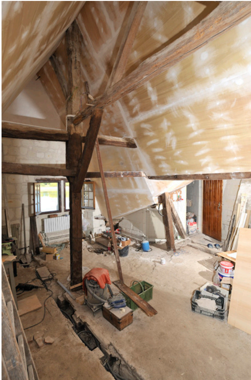
Charpente (vue vers le nord).
