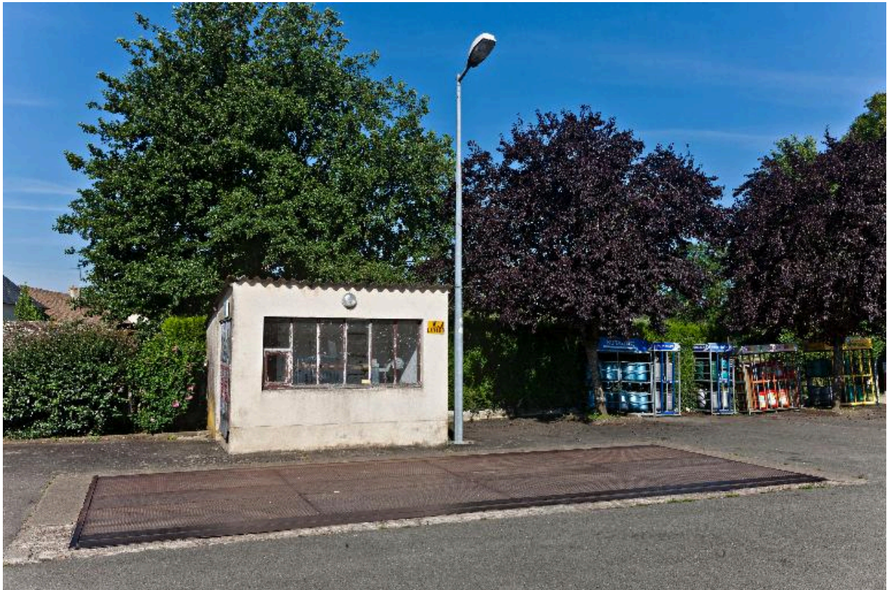
Bascule publique installée en 1969 place de la Bascule.
