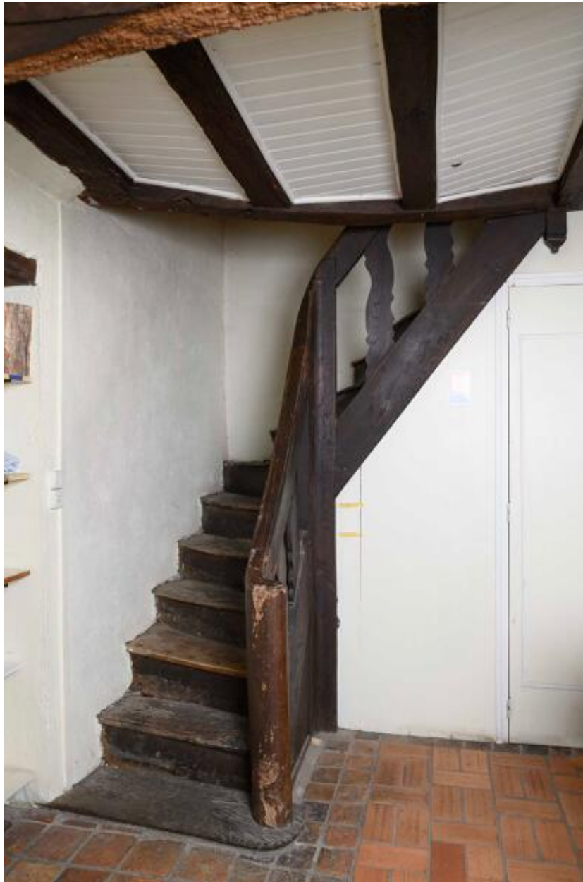
Vue de l'escalier de l'office.
