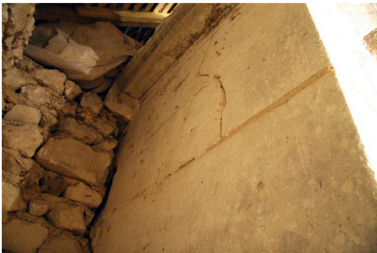
Ancien château, partie centrale, 1er étage, cheminée : détail de stéréotomie.
