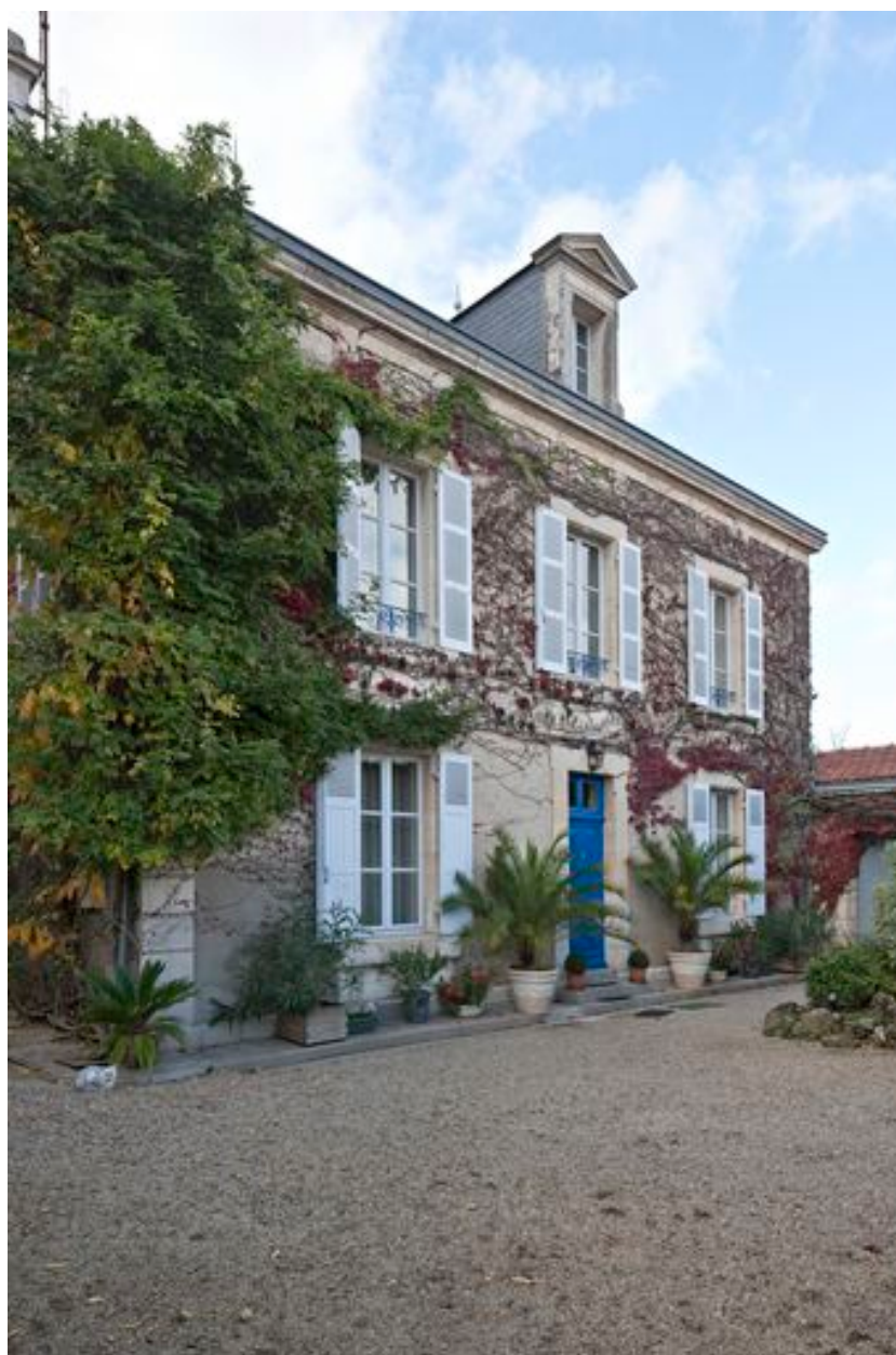
Maison 11, rue de Paris, construite en 1885 pour Alexandre Martineau.
