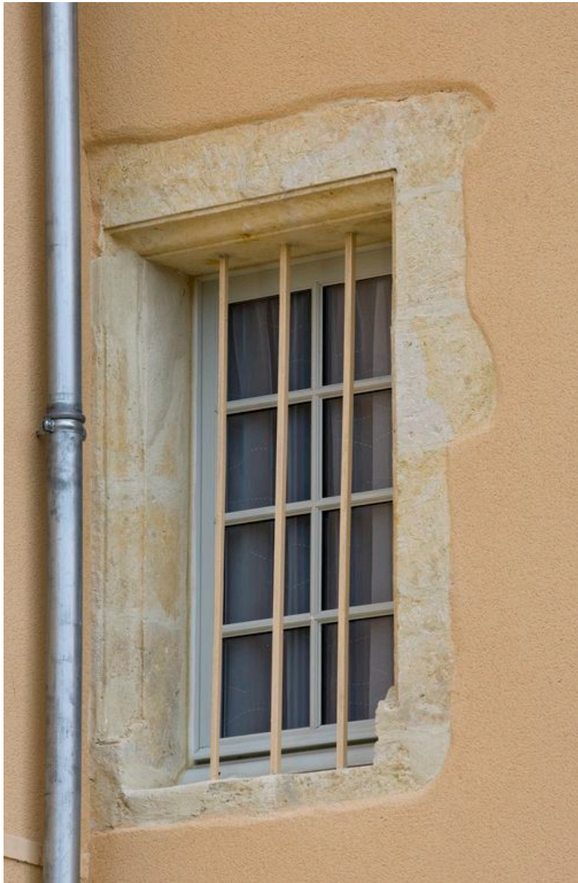
Fenêtre sur cour de l'étage carré de l'aile du logis
