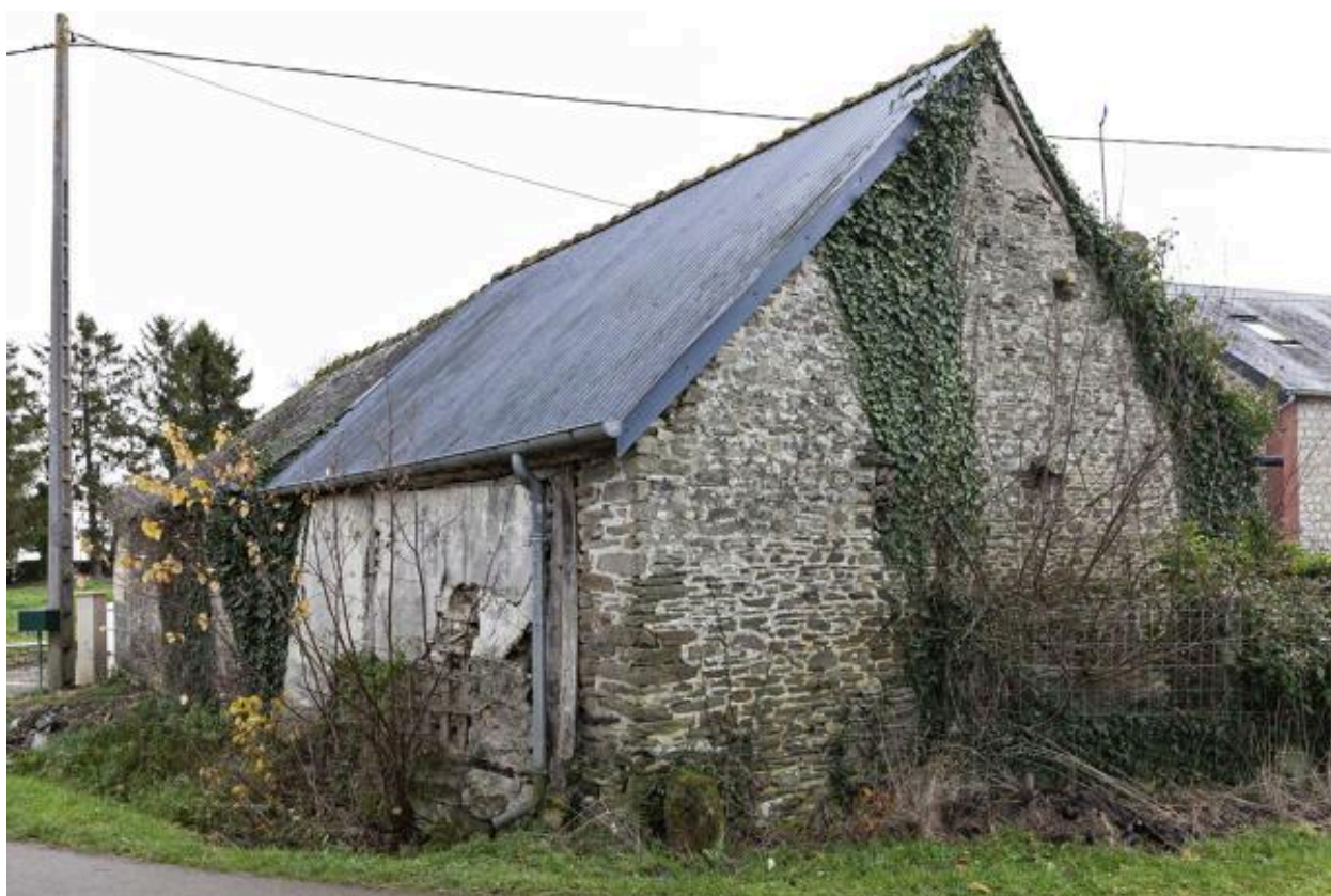
Mur-pignon occidentale de la maison en pan de bois de la Guiberdière.
