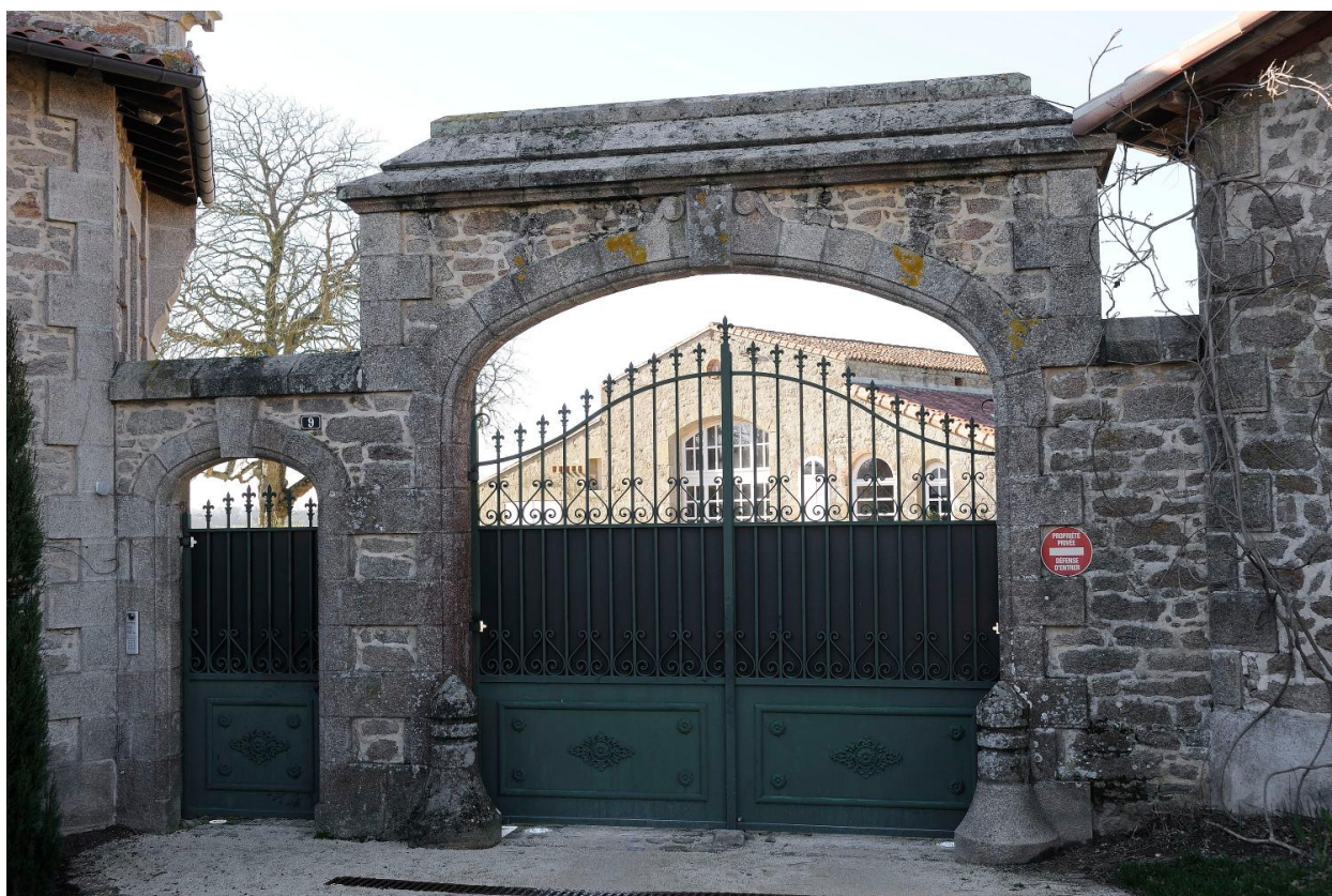
Vue du portail principal et en arrière plan de la grange-étable.
