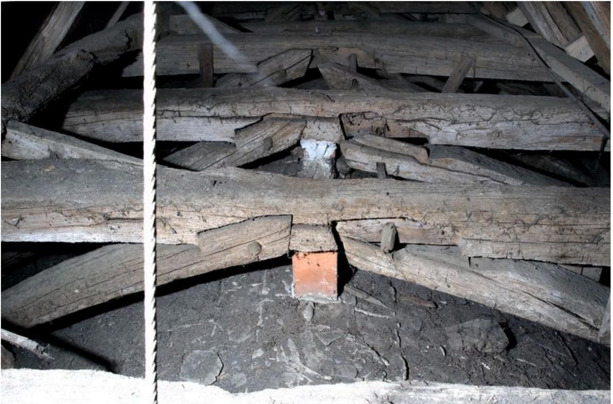
Charpente du chœur, 7e, 8e et 9e fermes, côté ouest : détail d'assemblage entre le faux entrait et les arbalétriers.
