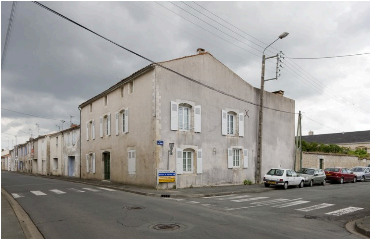
Vue d'ensemble de la maison, prise du nord-ouest.
