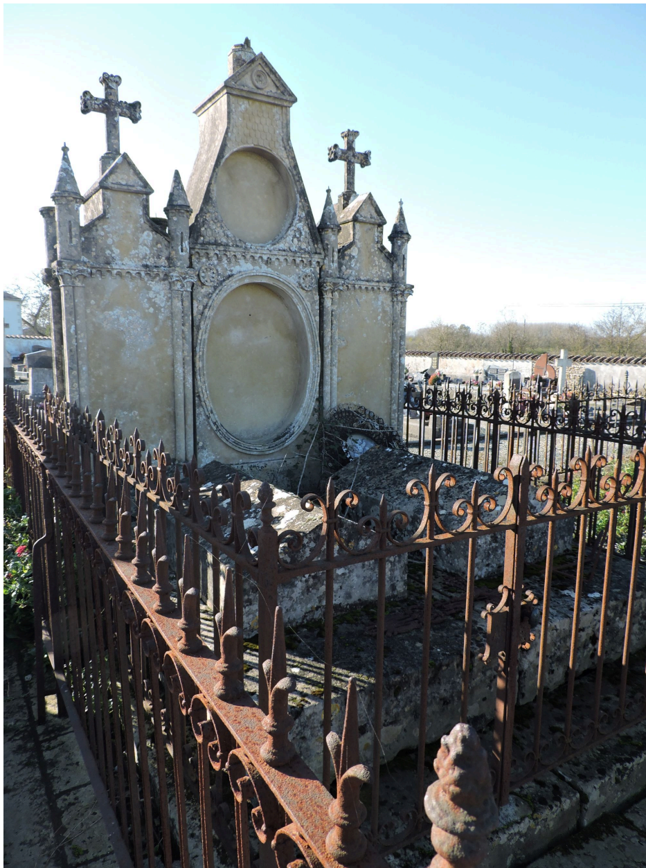
Vue d'ensemble, côté façade antérieure.
