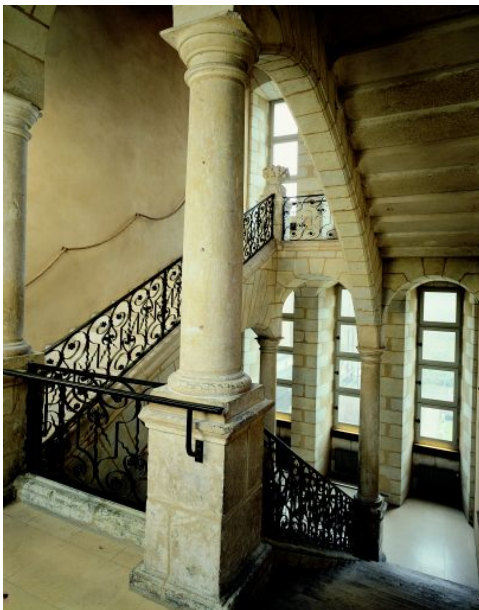
Le grand escalier depuis le palier du 1er étage.
