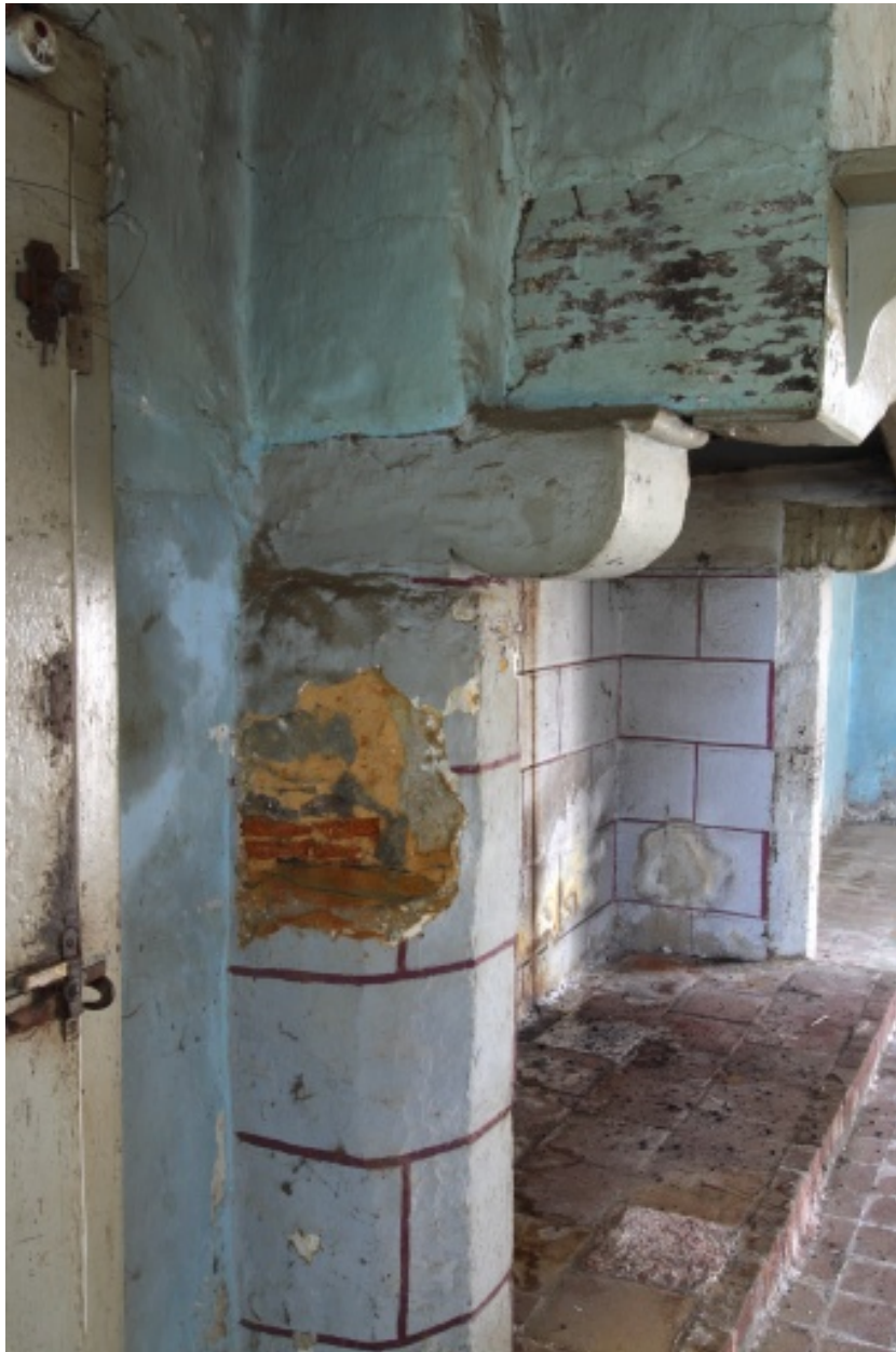
Intérieur du corps sud, rez-de-chaussée, avant les travaux : vue de détail de la cheminée.
