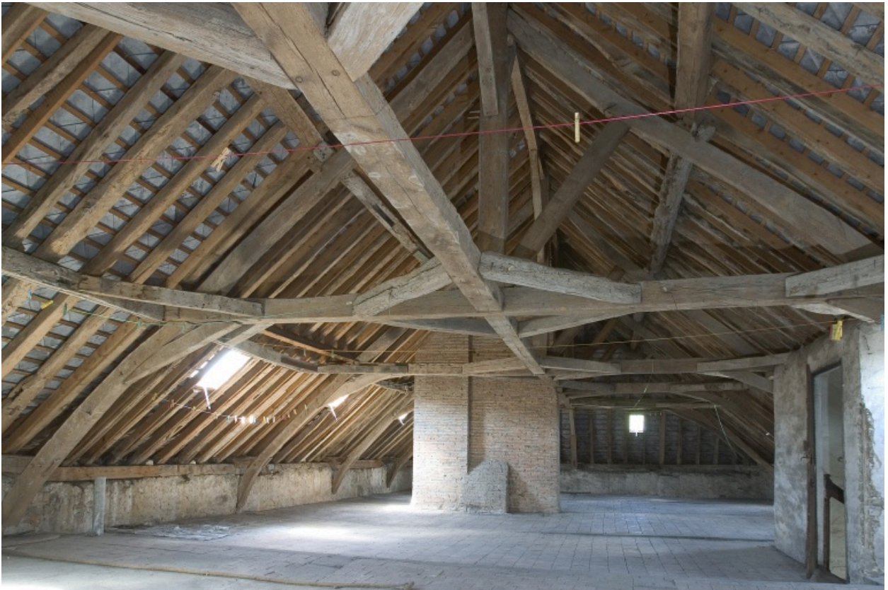
Comble du logis : la charpente du logis vue depuis l'est.
