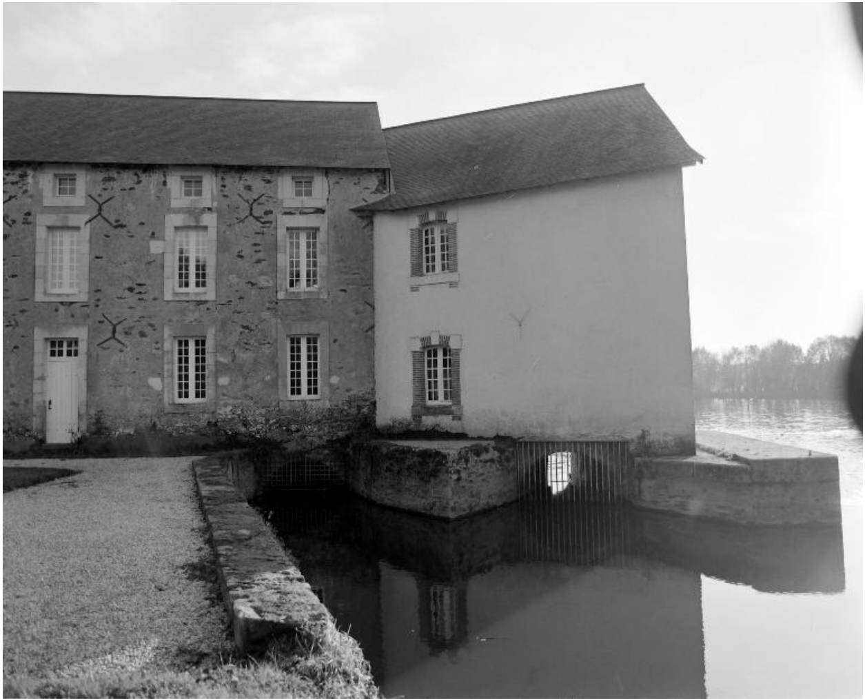
Façade nord du logement du meunier et du moulin. Les deux coursiers vus de l'amont.
