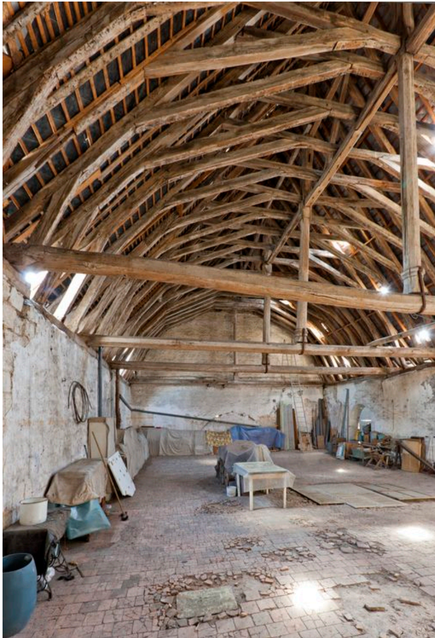
Charpente de la nef, vue prise de l'occident : pignon est avec la trace de l'arc diaphragme.
