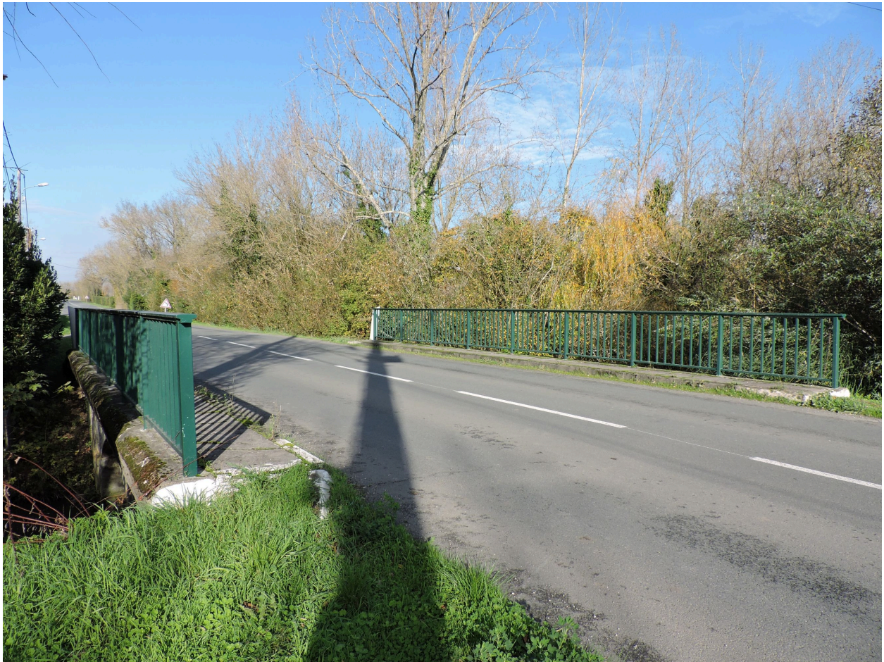
Le pont sur le canal de Vix vu depuis le sud-ouest.
