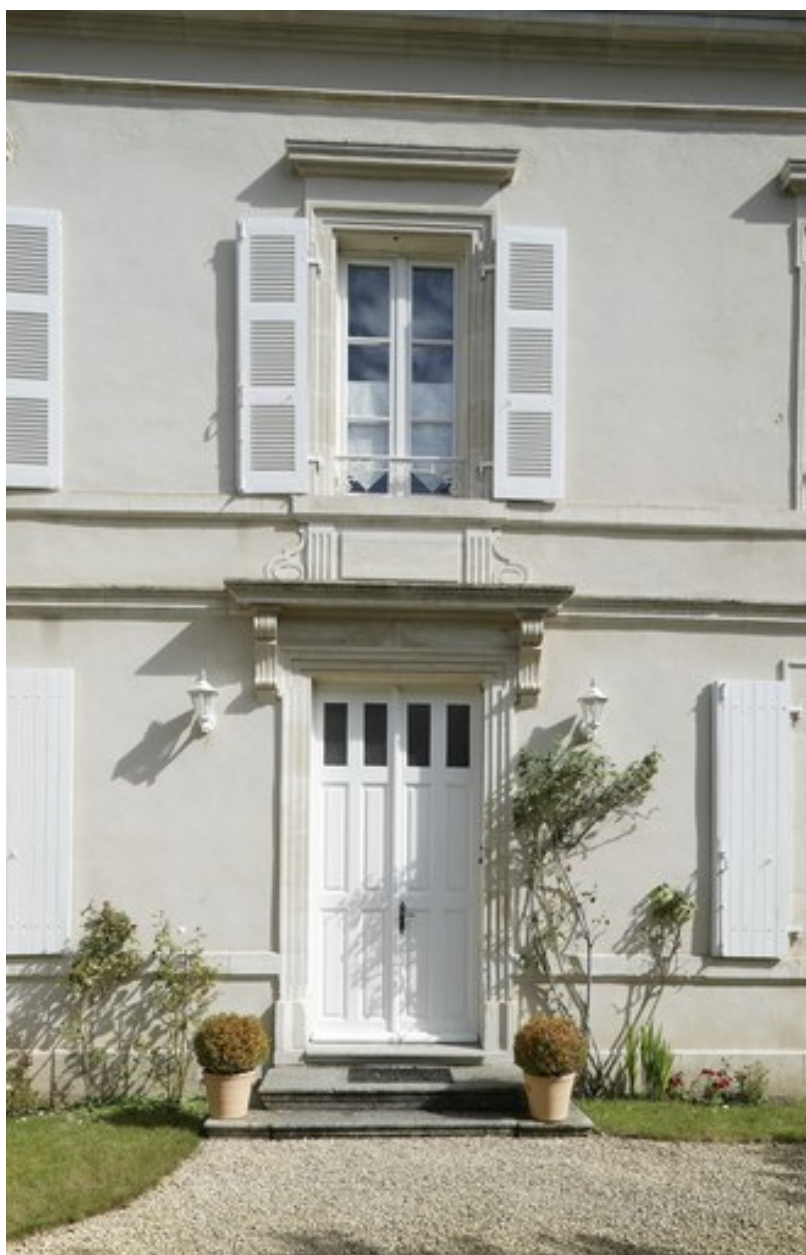
Porte d'entrée de la façade sur cour.
