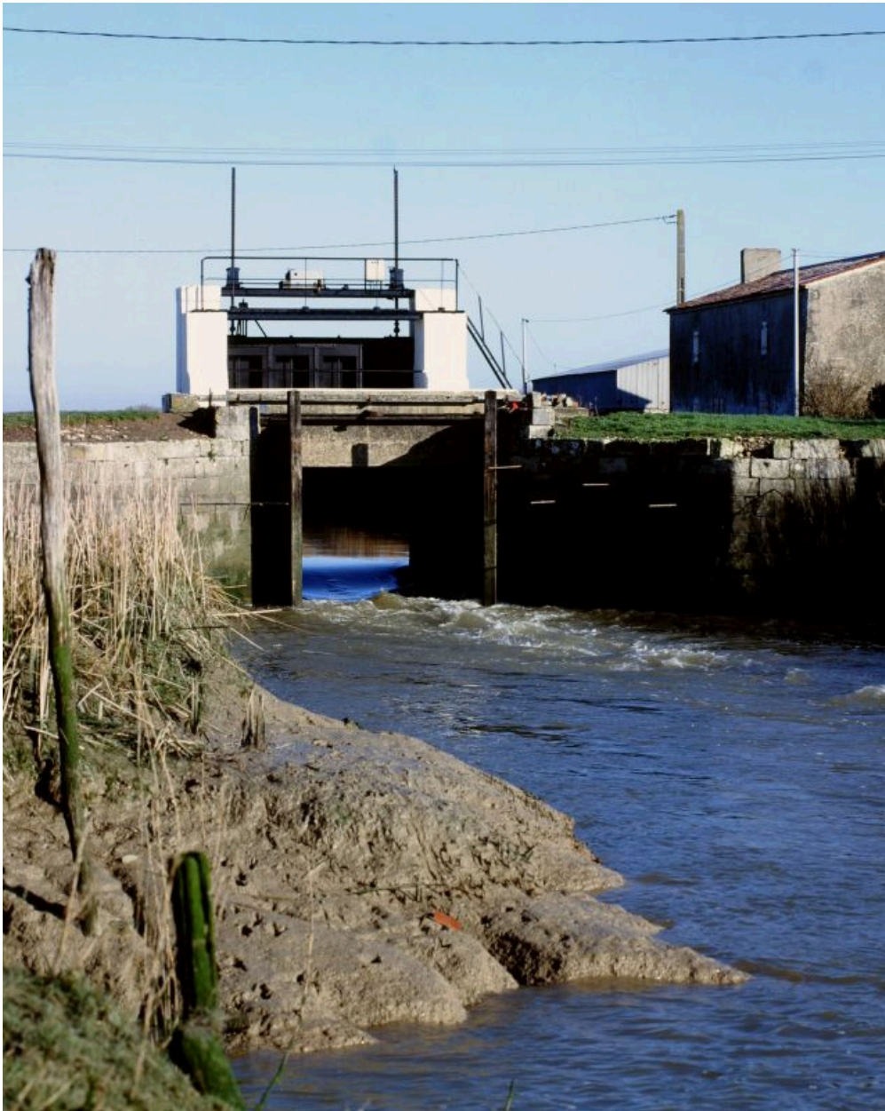
La porte vue depuis l'aval.
