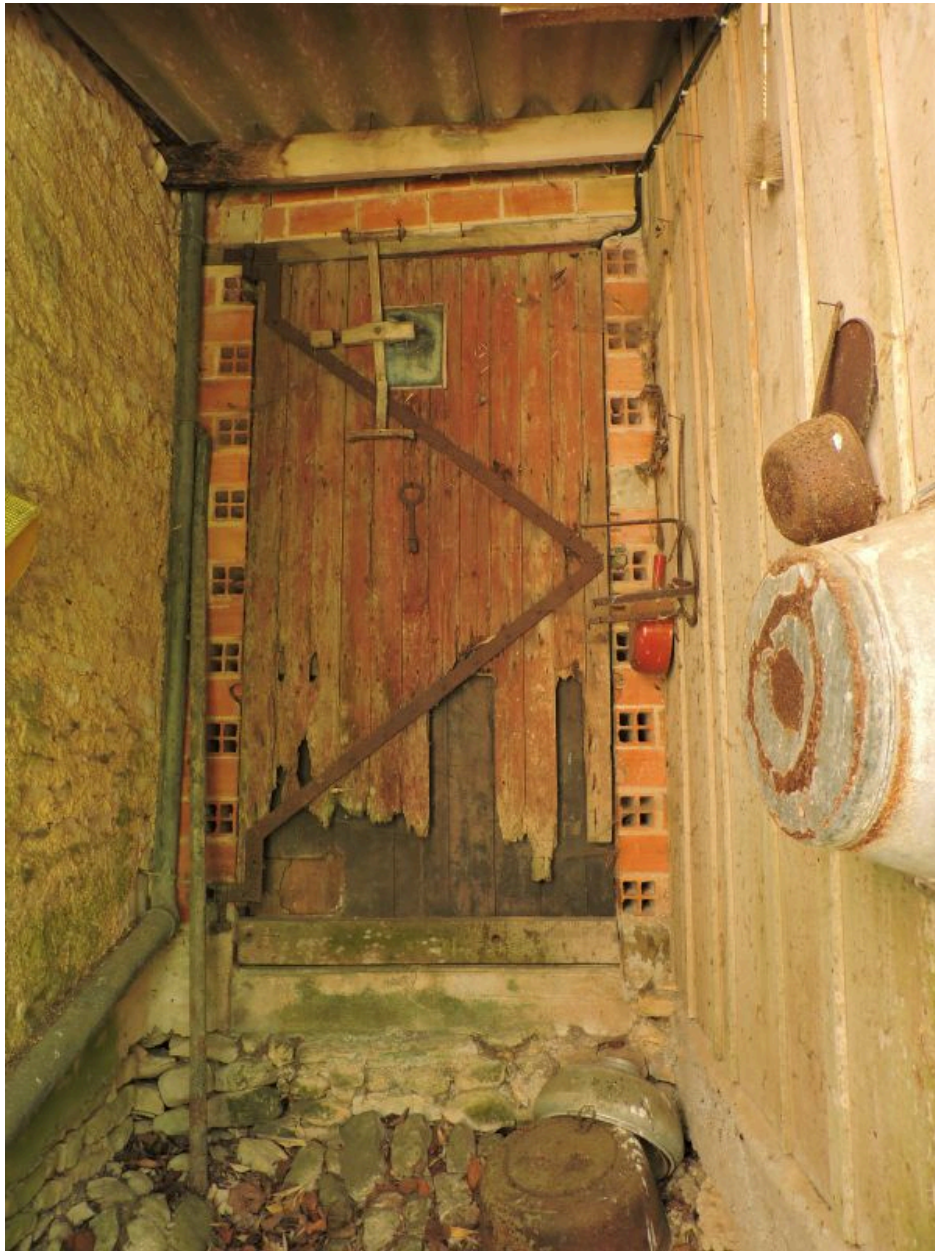
Porte au nord de l'étable.
