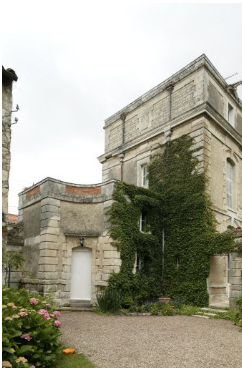
Vue prise du jardin, montrant la partie sud de la demeure.
