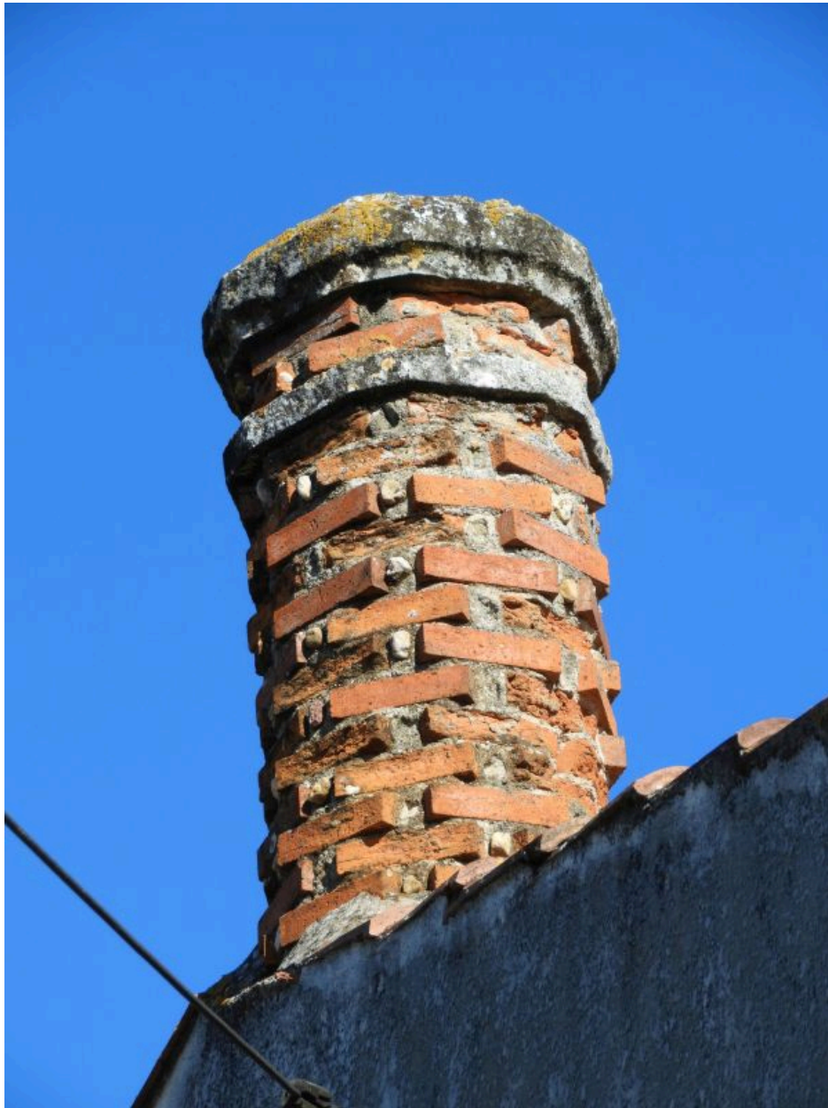
Une des souches de cheminée octogonales en brique.
