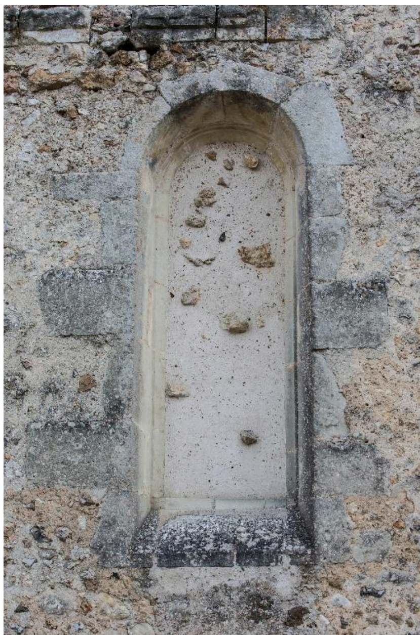
Tour-clocher, façade sud : baie murée (qui éclairait la chapelle 1).
