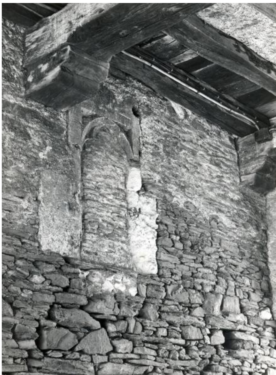
Passage couvert, rue de la Censerie, mur intérieur, est, détail.
