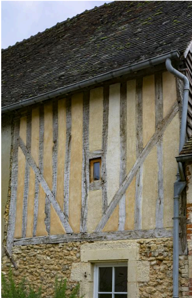
Le corps est, détail du pan-de-bois.
