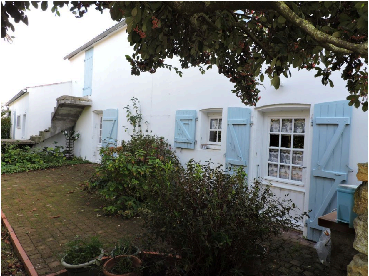
Ouvertures à linteau en arc segmentaire et escalier extérieur, sur le côté nord de la maison.
